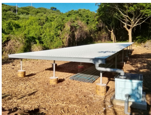
写真 9 赤島島内に設置した集水面「雨畑」
