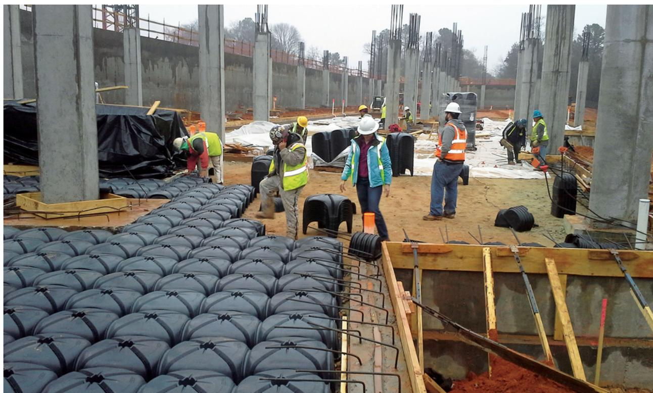
5) ここで働く労働者達は通気用床を取り付けている。昔からの気化物質軽減システムと同様に、通気用床は建物の地下から生じる気化物質を安全に屋外に排気することができる。
