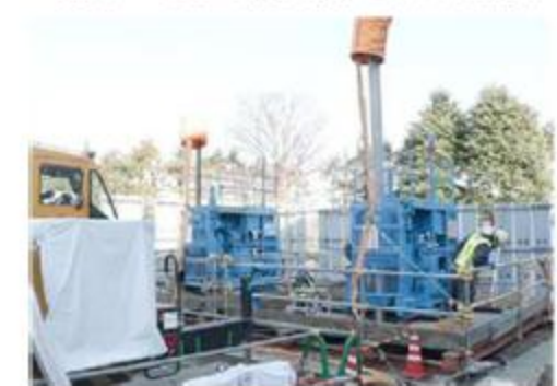
削孔・地盤改良体造成(近景)
