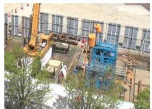
削孔・地盤改良体造成(全景)
