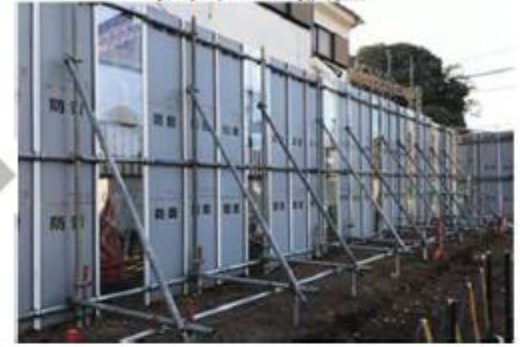
仮囲いの設置
