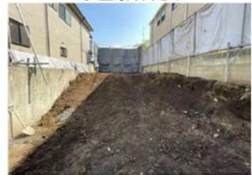
家屋解体完了
