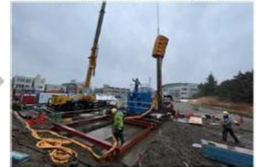
地盤補修マシンの据付
