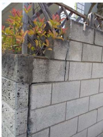
見回り調査で撮影した写真(2022年8月25日)と同じブロックをGoogle Street Viewの過去の写真(2019年6月)と照合。ブロックの亀裂が、陥没事故(2020年10月18日)に至る地下掘進工事の影響で大きく成長したと推測される。
