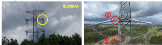
地震の揺れにより①ジャンパー線が②架線金物に接近
