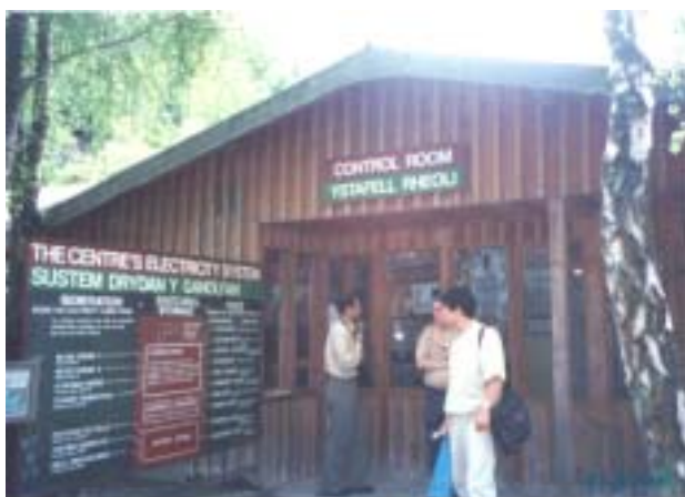
写真 3 : コントロールルーム
