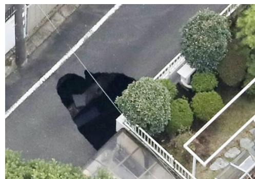
調布市 陥没事故現場
