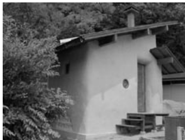
完成したストローベイルハウス
